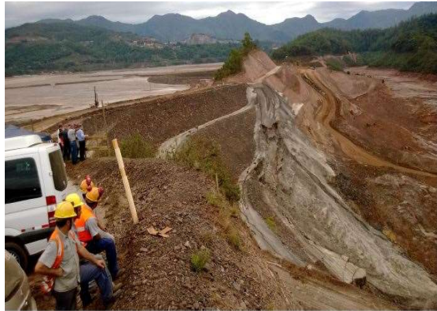
Ruptura de barragem de rejeitos
