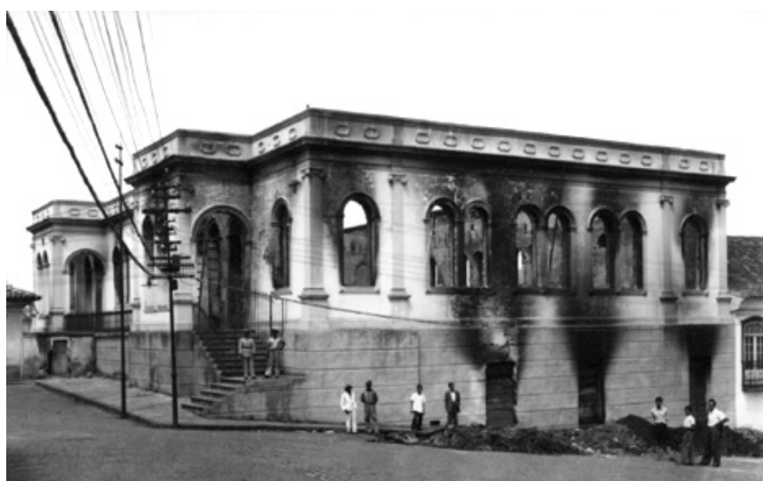
Foto: O Fórum de Ouro Preto após o incêndio. CAEM 96 anos em 2011.
